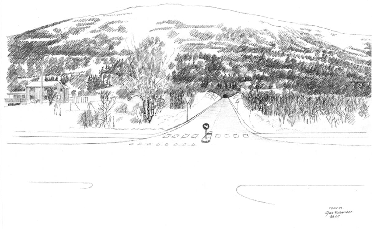
Figur 9 Dagsonen og tunnelportal i Nordbotn med skråninger ca. 1:4. Det anbefales at sideterrenget over ca 5 meter flates ut og brukes som beitemark.
