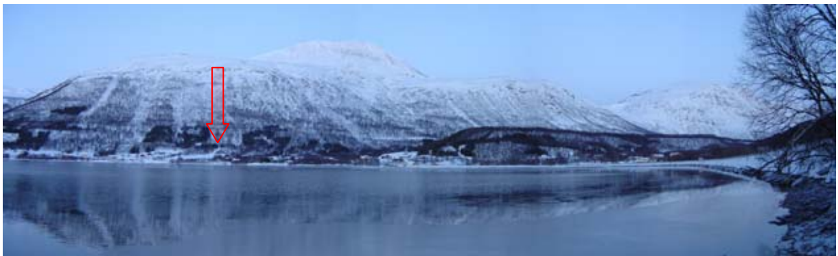
Figur 5 Nordbotn tatt fra Fagernessiden. Tunnelpåhugg er markert med rød pil
