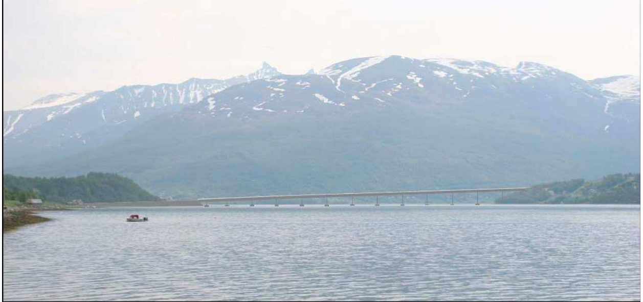
Fig 8.1: Bildemontasje av Vegvesenets påtenkte bru over Ramfjorden sett østover fra fjordmunningen. Fylling ca 450 meter til venstre, 10 meters høyde, bruhøyde ca 35 meter til høyre ved Hans Larsanes. Kilde Statens Vegvesen.
